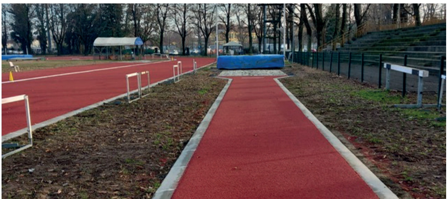
La pista del Campo Scuola dopo i lavori
